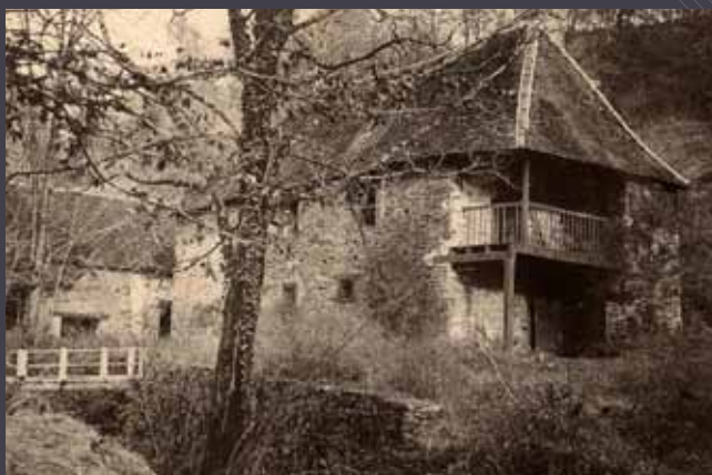
Partie habitée du moulin où se tenaient les résistants ; bâtiment détruit dans les années 1960. Photo R. Escaravage.
