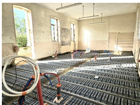
Septembre 2025, mise en place du plancher
