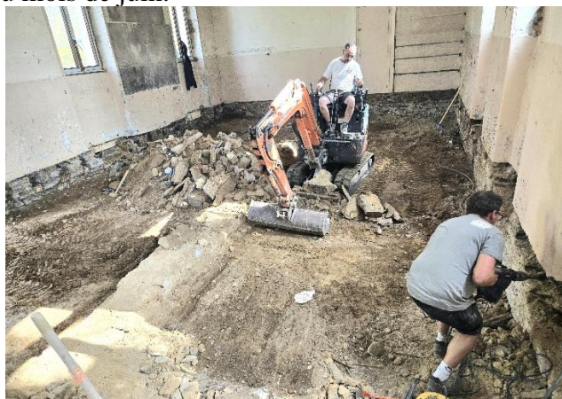
Août 2025, démolition de l'ancienne salle de classe
